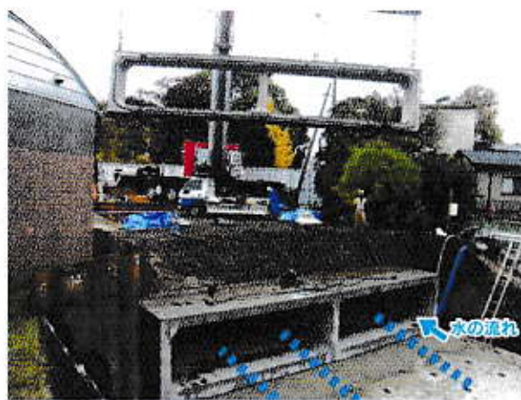
鷺川(暗渠水路)
