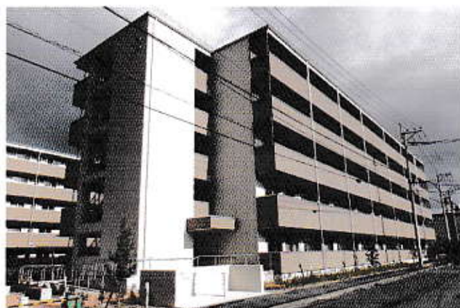
令和元年11月に完成した災害公営住宅南熊本第二団地
